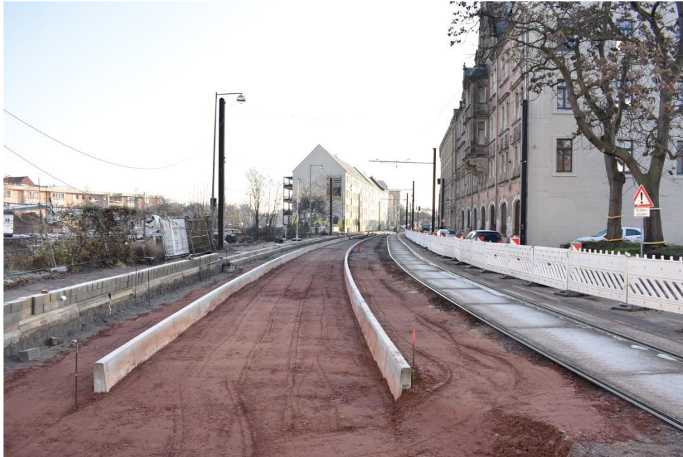
Bauarbeiten in der Schönebecker Straße
