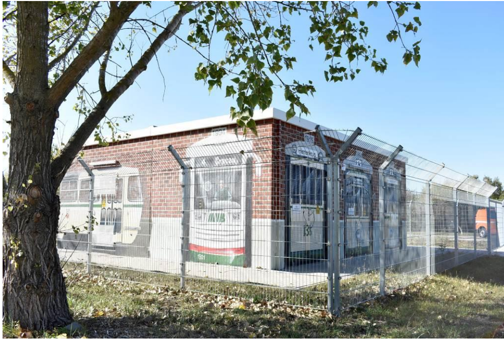
Unterwerk in Rothensee: „Fahrzeugparade“
