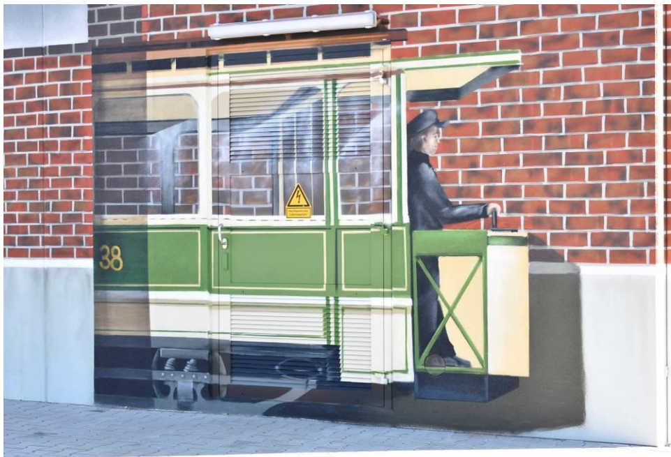
Unterwerk in Rothensee: Detailaufnahme des Triebwagens 38 von 1899
