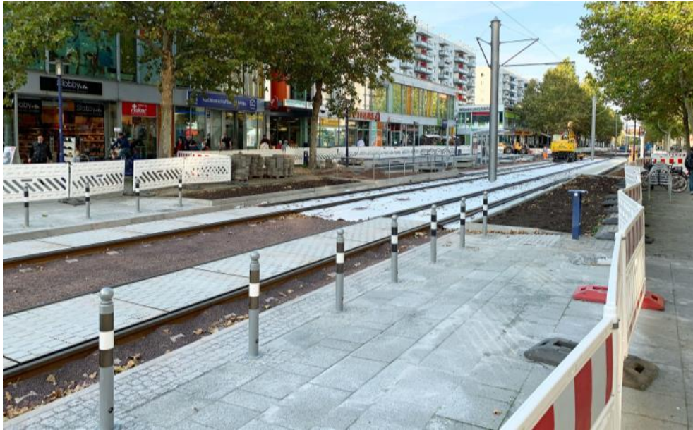
Neue Gleise und neuer Überweg.
