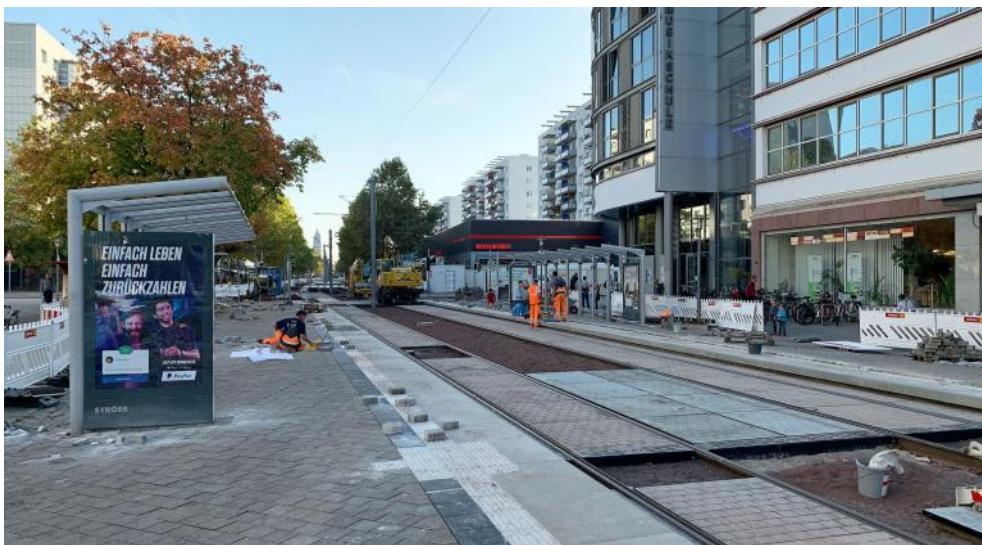
Die neue Haltestelle Opernhaus im Entstehen.
