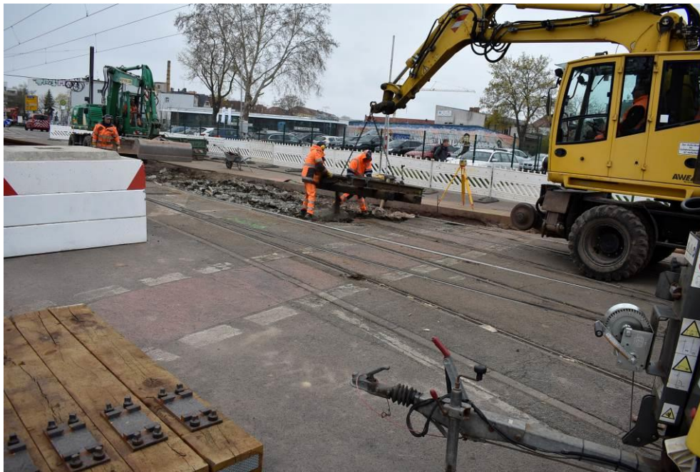
Einbau der Weichen.
