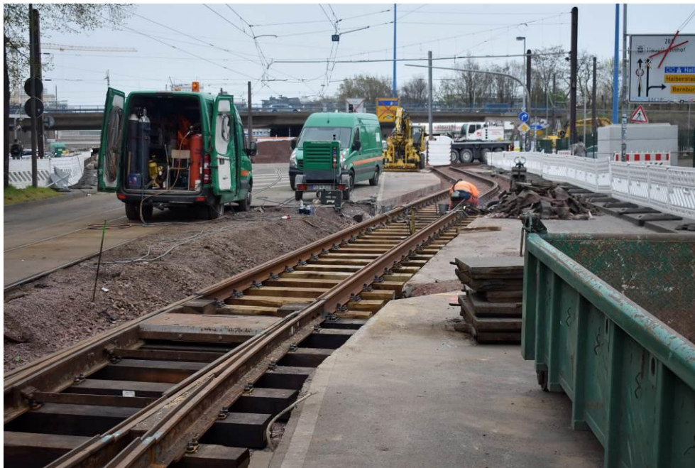
Das Baugleis am Damaschkeplatz.
