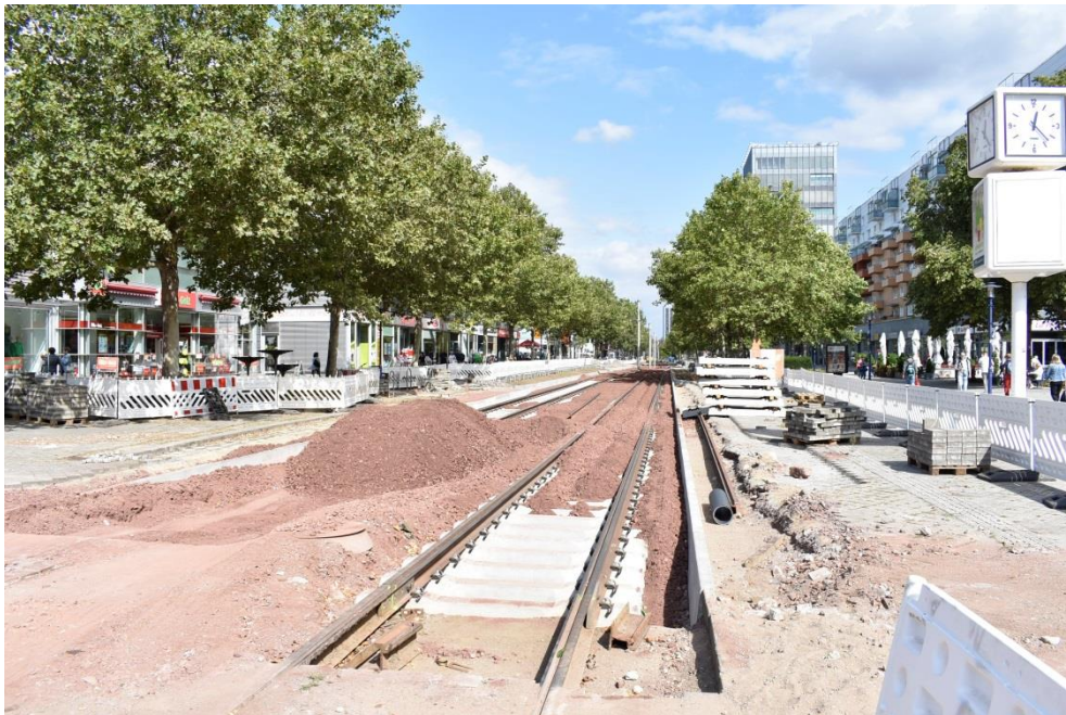
Blick über den Breiten Weg mit neuen Schienen
