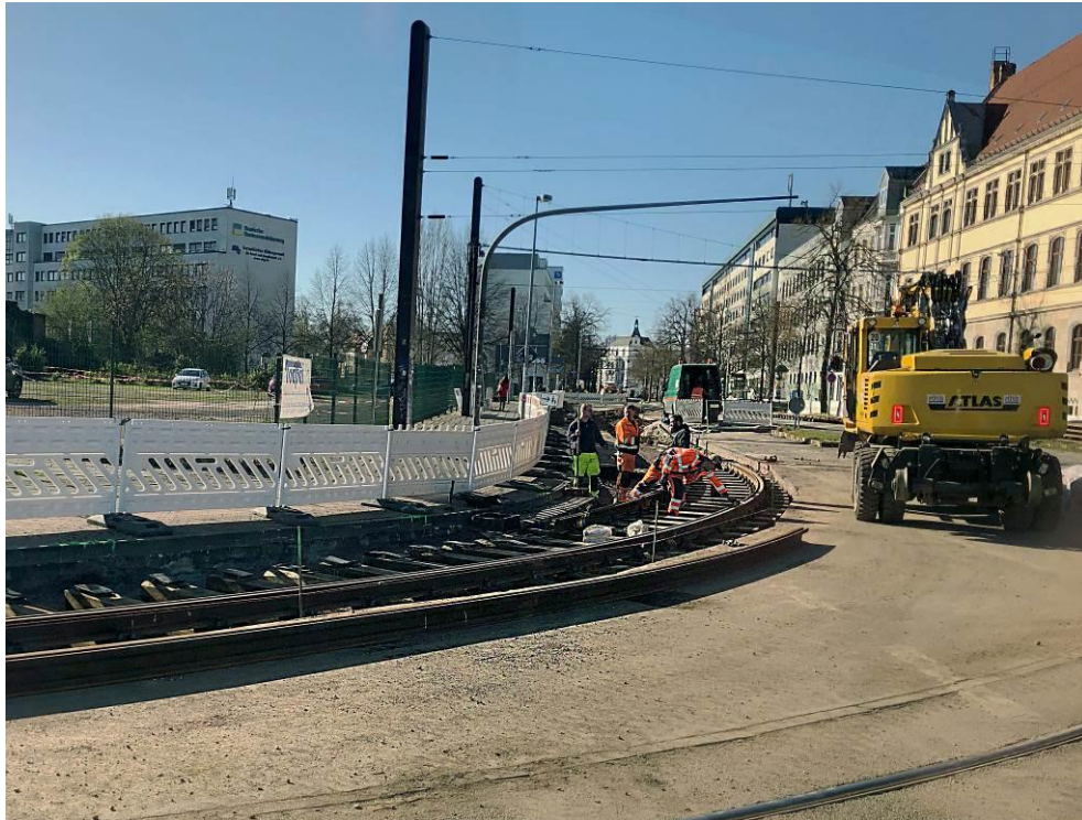
Das neue Gleis am Damaschkeplatz - Straßenbahnen können so die Baustelle umfahren.
