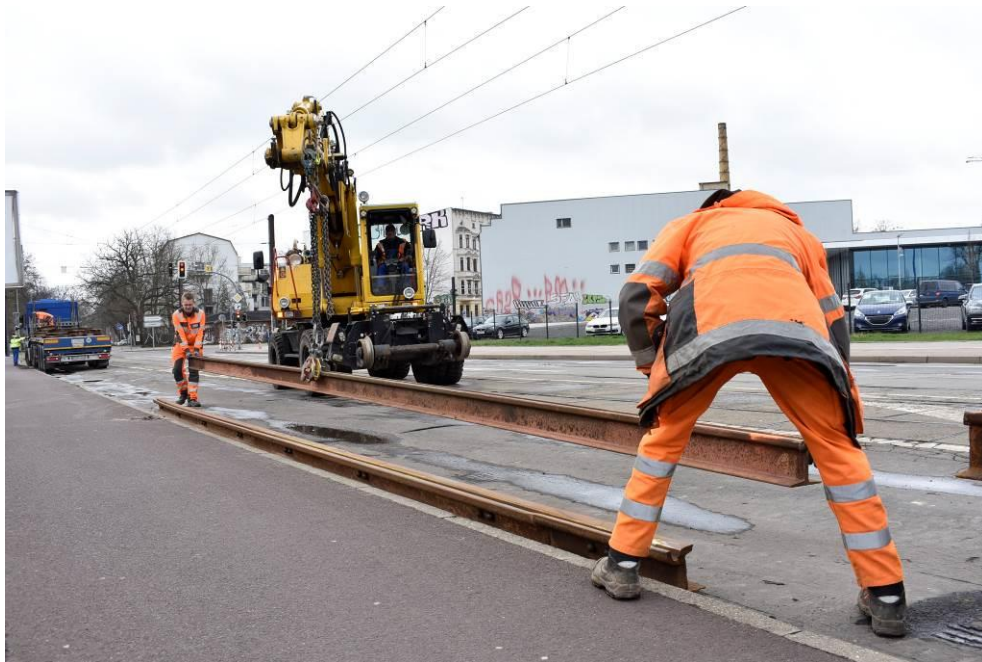
Neue Schienen für den Damaschkeplatz
