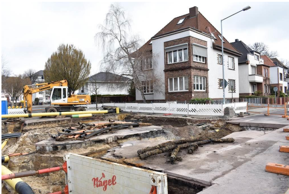
Kanalbauarbeiten an der Liebknechtstraße für einen Regenwasserüberlauf
