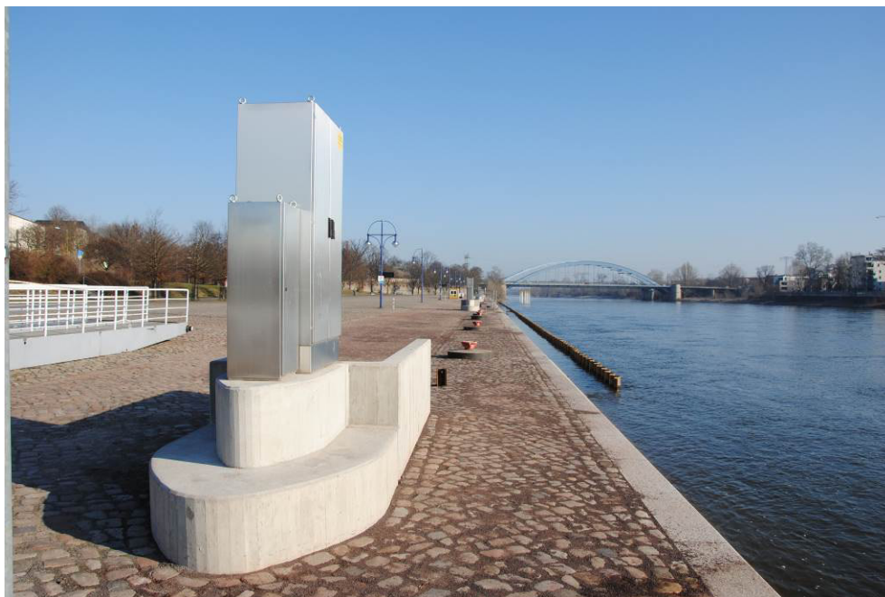
Neues Pflaster und neue Elektroanlagen
