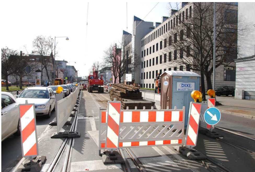
Gleisbauarbeiten in der Halberstädter Straße
