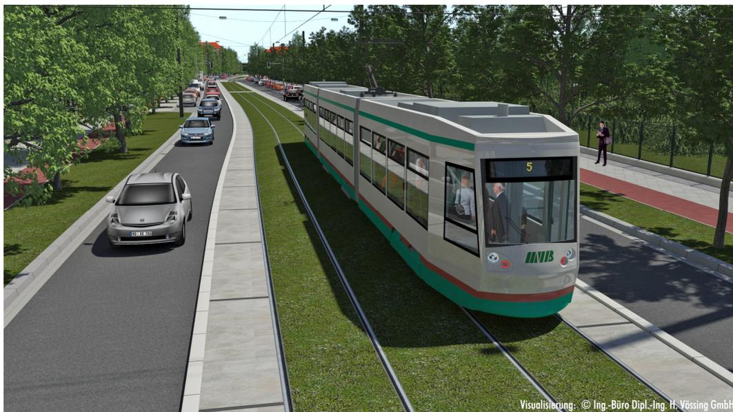
*Visualisierung: Raiffeisenstraße nach den Bauarbeiten mit Rasengleis und neuer Baumallee*
