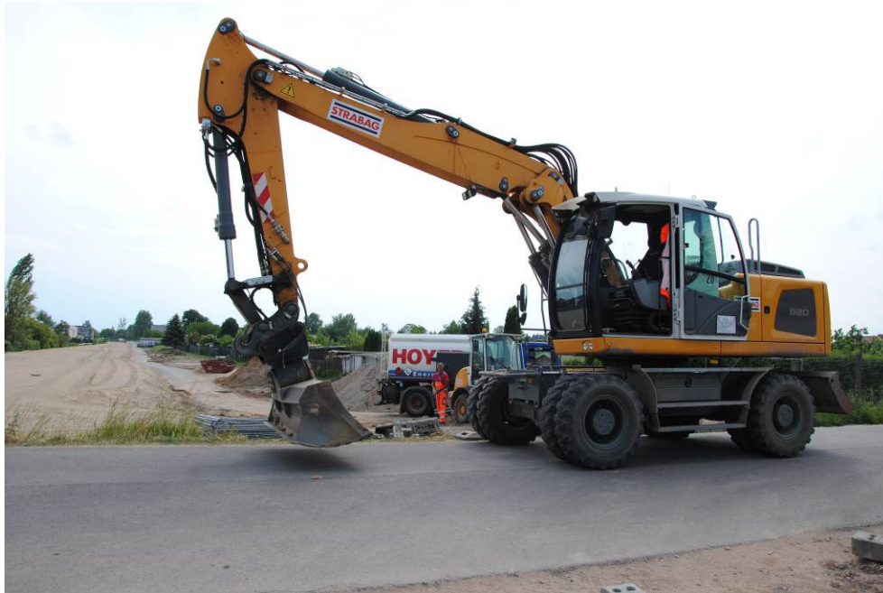
Bodenverbesserungsarbeiten für die neue Gleistrasse
