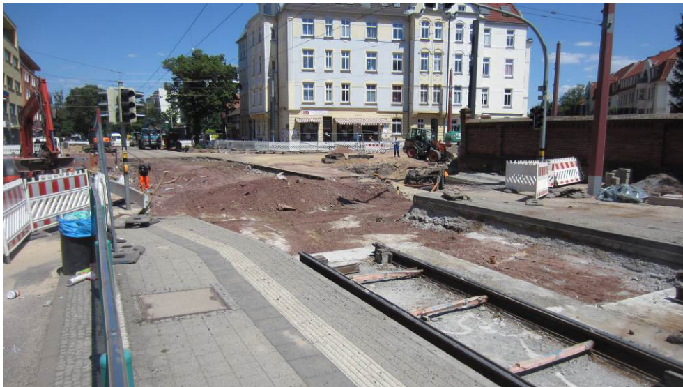
Blick auf die Kreuzung mit bereits demontierten alten Gleisen.
