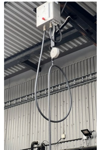
Abb. 61: CCS Anschlussbox mit Seilzug-Abrollsystem
